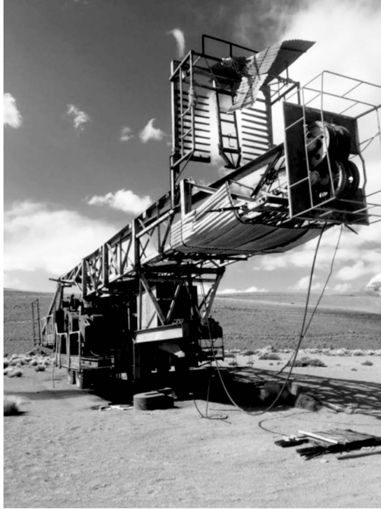
Figura 17: Infraestructura geotérmica abandonada en el Tatio; Elaboración propia (2019).
